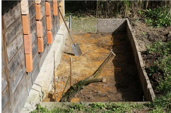
Anlage eines Sandariums vor der Trockenscheune von wildbiene.com. Für das Sandbeet wurde der ursprüngliche Boden 50 cm tief entfernt. Damit keine Pflanzen aus den umliegenden Beeten in die Sandfläche einwandern, wurden alte Betonplatten als Wurzelsperre eingebaut. Im nächsten Schritt wurde in die Grube Feinsand eingefüllt.
